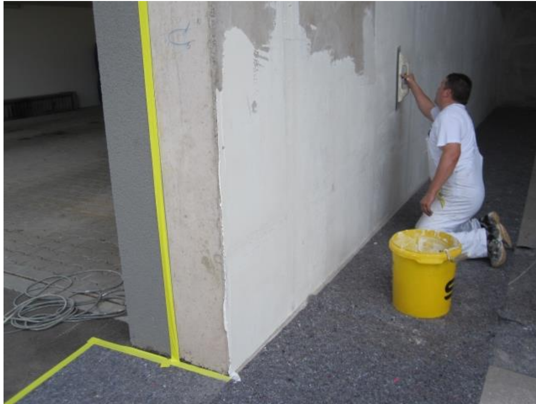
Schließen der Löcher und Lunker mit Egalisierspachtelung
