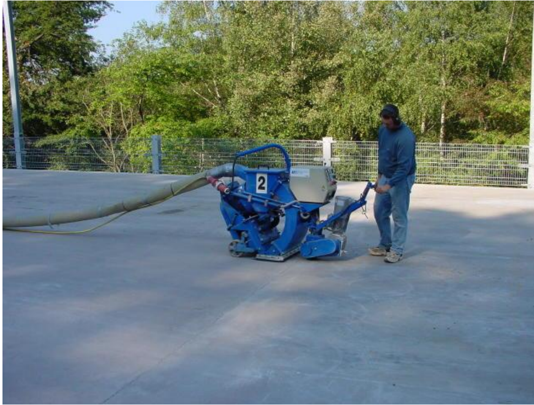
Untergrundvorbereitung Boden Kugelstrahlen
