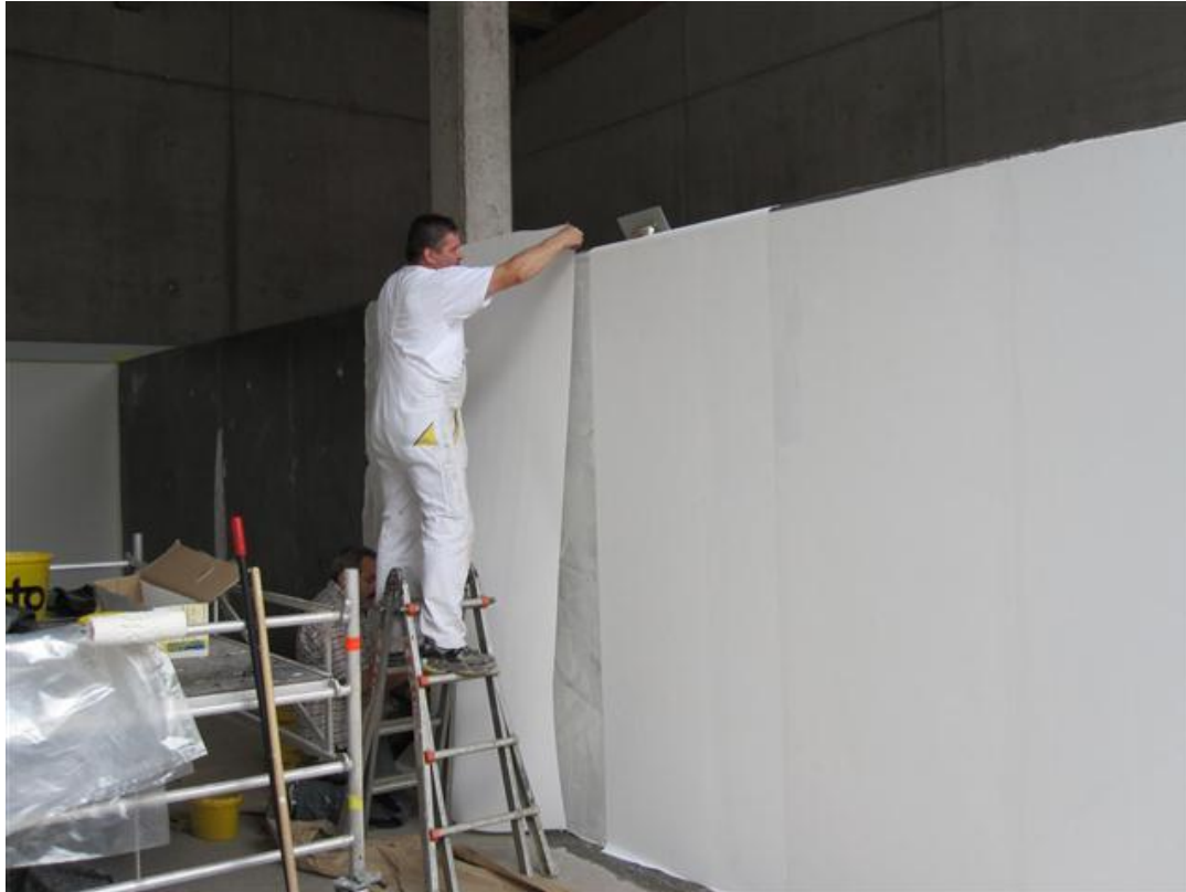
Aufbringen Glasfaservlies zur Rissüberbrückung
