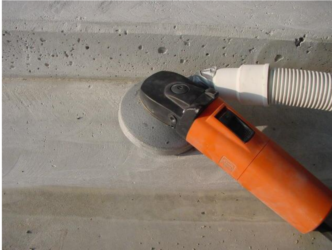
Untergrundvorbereitung Randbereich Schleifen
