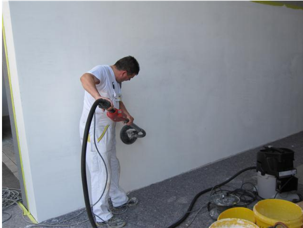
Schleifen der Fläche mit Giraffe zur Beseitigung von Graten
