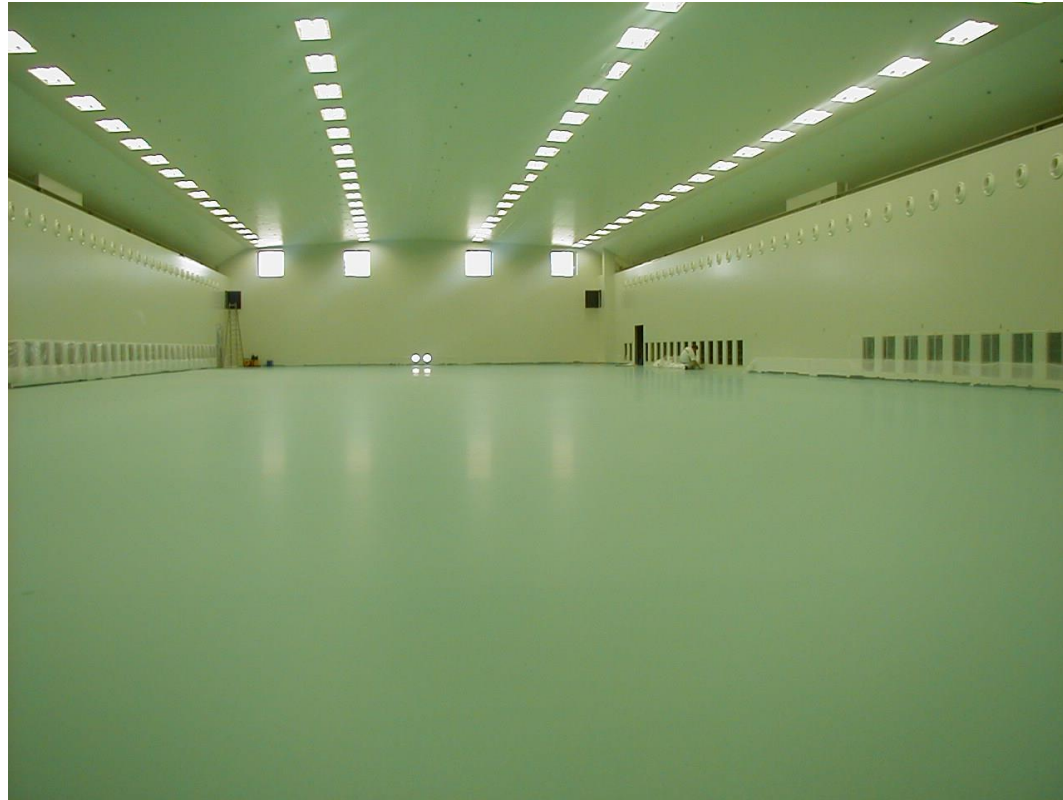
Beschichtungen auf Wand/Decke/Boden
